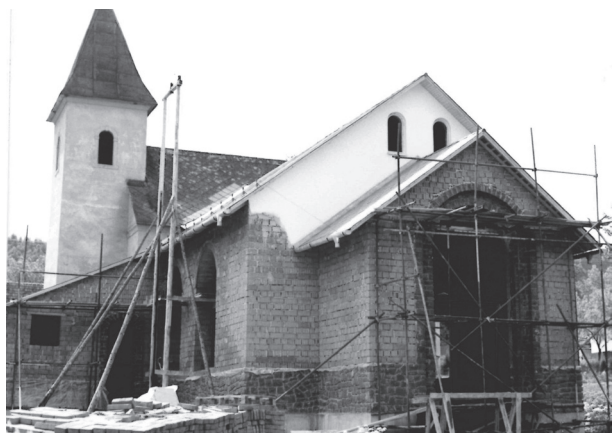
Prístavba kostola vo Veľkej Lehôtke. Foto: Jozef Bullo st.
